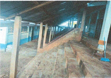
Foto 5: VISTA INTERIOR DE TRIBUNA ESCOLAR
