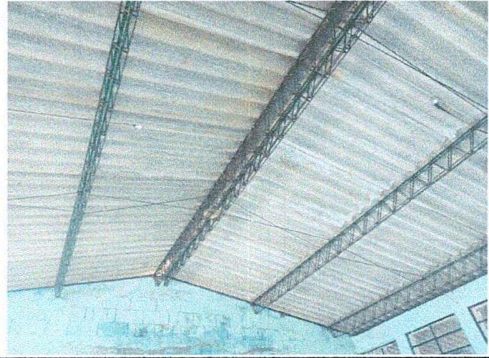
Foto 2: TERCERO "A" CAMBIO DE CUBIERTA DE LAMINA
