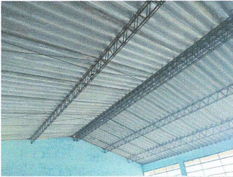
Foto1: AULA DE SEGUNDO "A" CAMBIO DE CUBIERTA DE LAMINA
