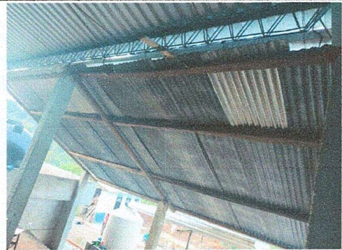
Foto 4: SERVICIO SANITARIO CON TERRAZA CAMBIO DE DEPOSITO DE AGUA.
