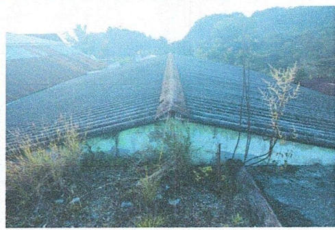
Foto 6: VISTA DE TECHO DE AULAS DE SEGUNDO "A" Y TERCERO "A"
